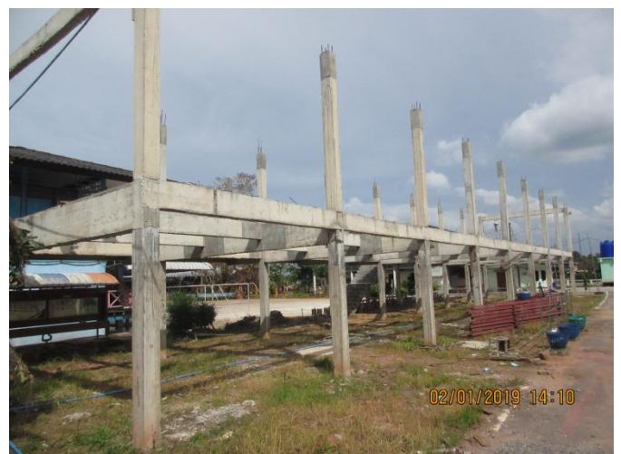
ด้านหลังอาคาร
